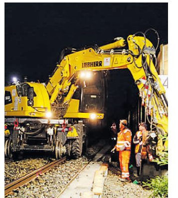
Gearbeitet wurde teilweise auch nachts.
