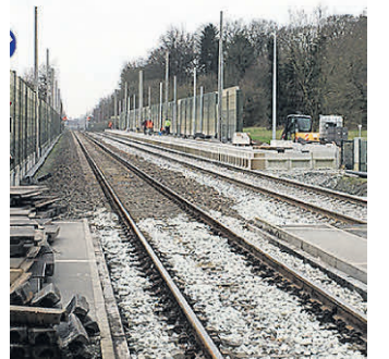
Anfang 2020 ist der Haltepunkt schon gut erkennbar.
