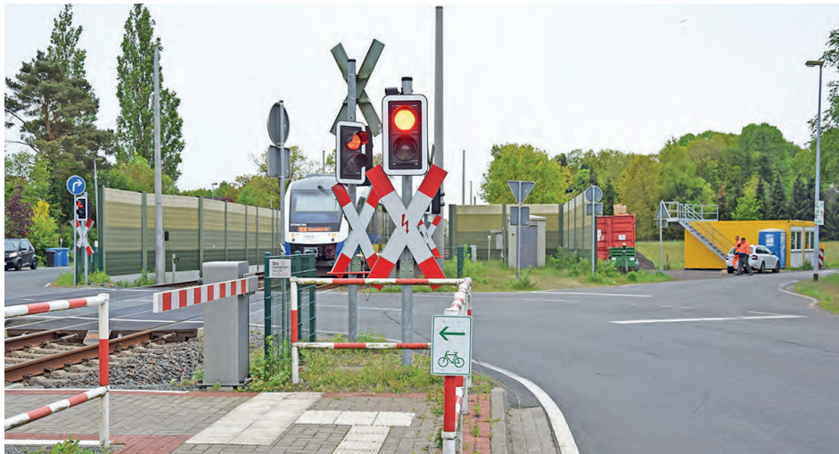
Das Baustellenbüro ist eingerichtet (hinten rechts im Bild), in der kommenden Woche geht es los: Zuerst wird der Bahnsteig in Fahrtrichtung Oldenburg im Bereich zwischen Georgstraße und Gleisen errichtet.
